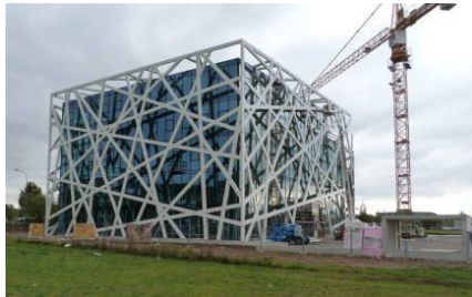
Bild 10 Mit BIM geplantes Stahlskelett aus 1.144 Stahlhohlprofilen [Vorndran Metallbau tekla.com/de/referenzen/qbig-reizvoller-stahlbau-heilbronn ]
